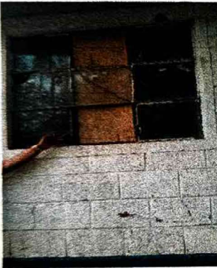
Foto 3: Sustitución cambio de ventana por metal.
